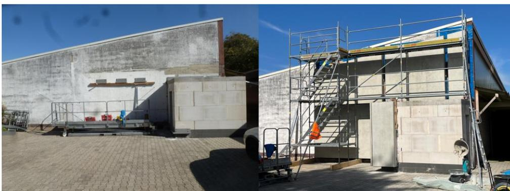
**Abbildung 9: Umsetzung der Demonstrationsfassade bei KOMZET BAU in Bühl in Ausgangslage (links) und mit montierten Sandwichfassaden-Elementen (rechts)**
