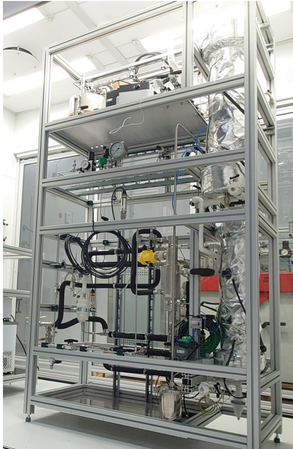
Abb. 2: MEGA-Demonstrationsanlage im Technikum des LIKAT.
