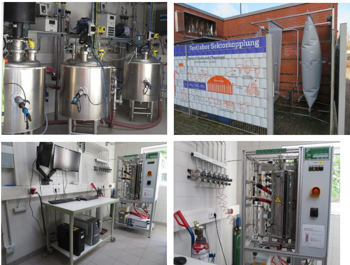
Abbildung 1: Testlabor Sektorkopplung – Power-to-Fuels-and-Chemicals (P2FC) der Hochschule Flensburg mit Biogas-Pilotanlage (oben links), Biogas- und Methan-Gasspeicher (oben rechts) sowie Teststand der katalytischen Methanisierung (unten)
