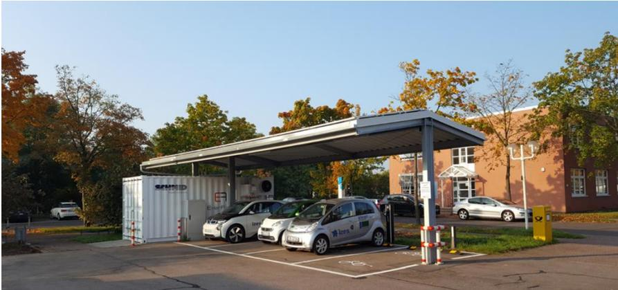
**Abbildung 4:** IZES „Solar-Carport“ mit Vanadium-Redox-Flow-Batterie und PV-Anlage (Bildquelle: IZES)
