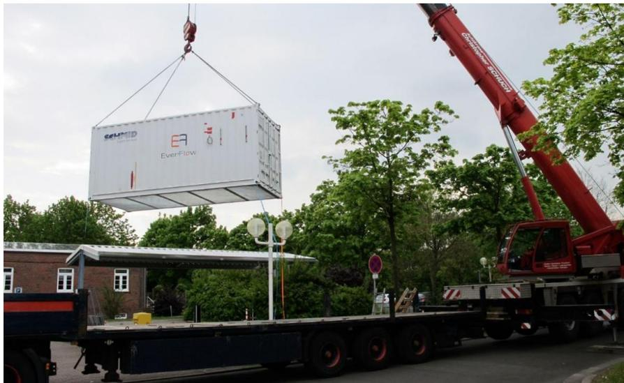
Abbildung 1: Lieferung und Aufstellung des Batteriecontainers (Bildquelle: IZES gGmbH)
