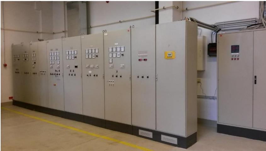
Abbildung 1: Aktuell vorhandene Schaltanlage
