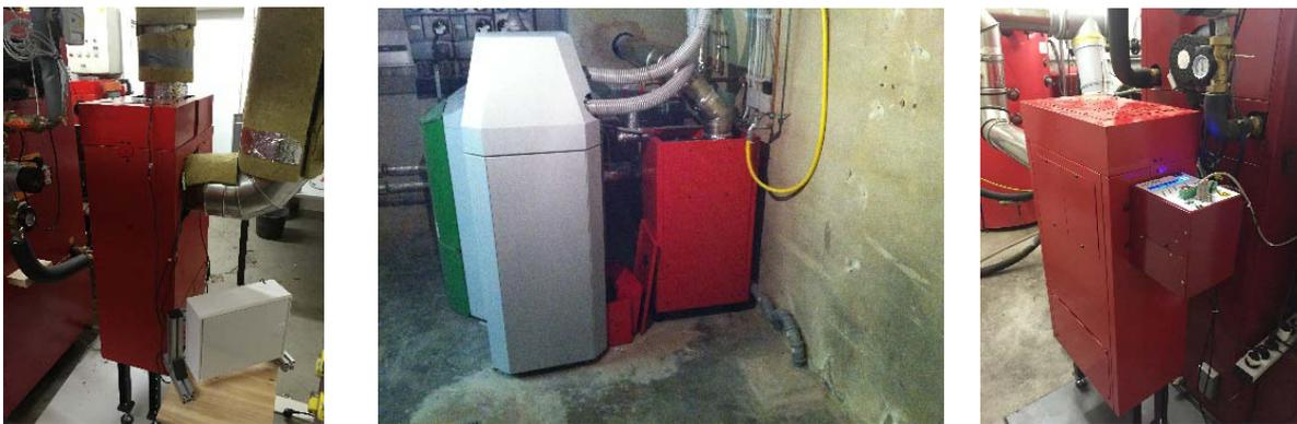
Abbildung 3: Links: 50 kW<sub>th</sub> Stückholzkessel mit EFC Filterbox 50 am Standort Saarbrücken I; Mitte: 13 kW<sub>th</sub> Pelletkessel mit EFC Filterbox 50 am Standort Ensdorf; Rechts: 36 kW<sub>th</sub> Pelletkessel mit EFC Filterbox 50 am Standort Vaduz
