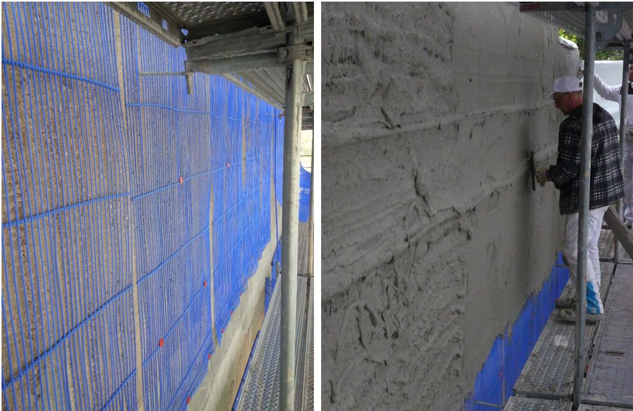
Abbildung 4: Kapillarrohrmatten der aWT auf der Feldtestfassade (links). Einputzen der Kapillarrohrmatten mit 10 mm Klebemörtel (rechts) [Bildquelle: IZES gGmbH].
