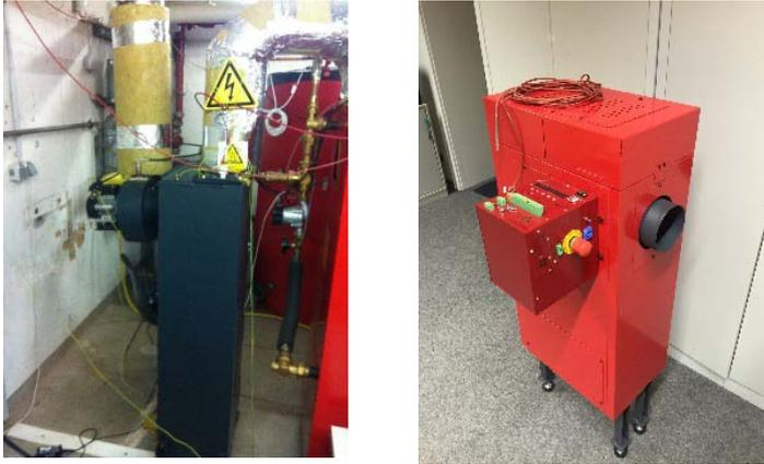
Abbildung 2: Links: EFC Filterbox 100 für Kessel mit einer Nennwärmeleistung bis 100 kW (Abbildung ohne Wärmeisolation); Rechts: EFC Filterbox 50 für Kessel mit einer Nennwärmeleistung bis 50 kW
