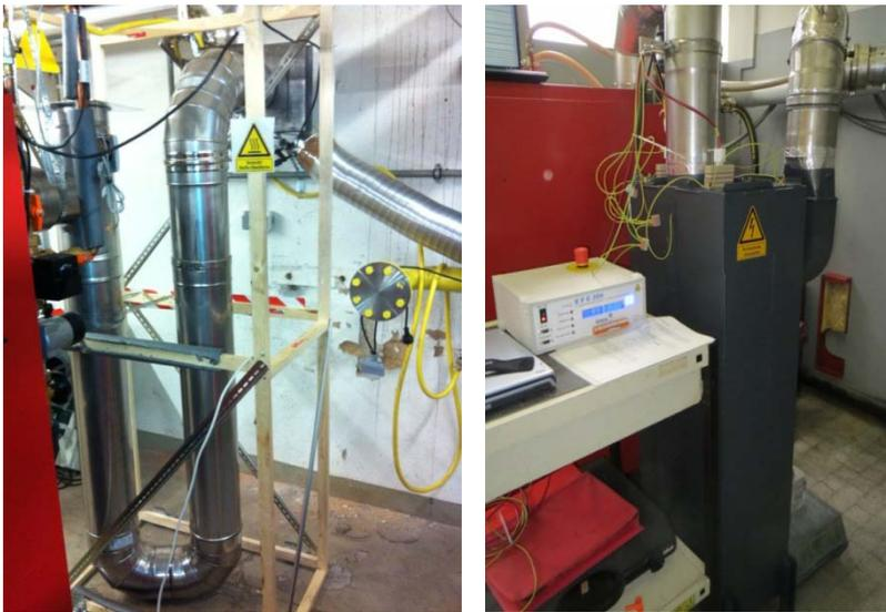
**Abbildung 8: Filteranbau HOVAL Stückholzkessel bei IZES (links) und HOVAL (rechts)**
