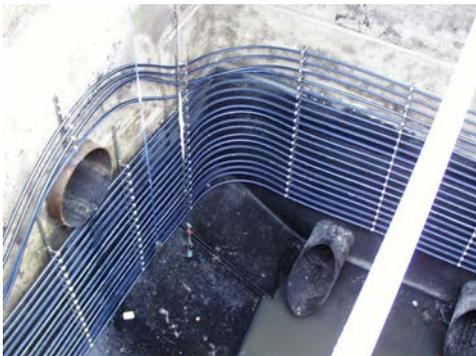
In diesem Behälter der zentralen Pumpstation, die das Wasser zum Klärwerk befördert, sind unter Berücksichtigung aller spezifischen Eigenschaften des Abwassers entsprechende PE-Wärmetauscherrohre installiert, über die mittels Solekreislauf der Wärmepumpe dem Wasser die Energie entzogen wird. Diese Wärmepumpen-Anlage der Güstrower Stadtwerke wird seit über 13 Jahren zur Zufriedenheit des Kunden betrieben und spart neben Kosten für eine aufwändige Quellenerschließung jetzt jährlich Heizkosten.
