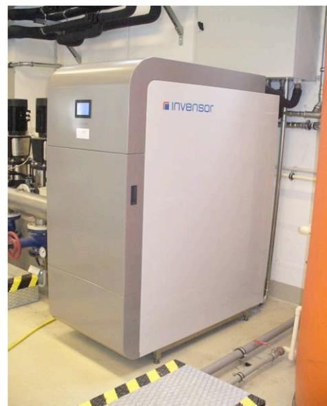
Bild 1: Adsorptionskältemaschine
