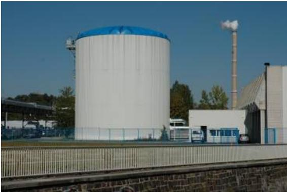
Abb. 1: Zentrale Kälteerzeugung der eins energie in sachsen in Chemnitz, Kaltwasserspeicher (in der Mitte), Speicherschnittstelle mit Unterleitstation und hydraulischer Verteilung (halbrechts), Gebäude mit Kältemaschinen und Rückkühltechnik (rechts)
