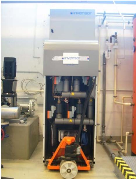
Bild 1 Adsorptions-Kältemaschine
