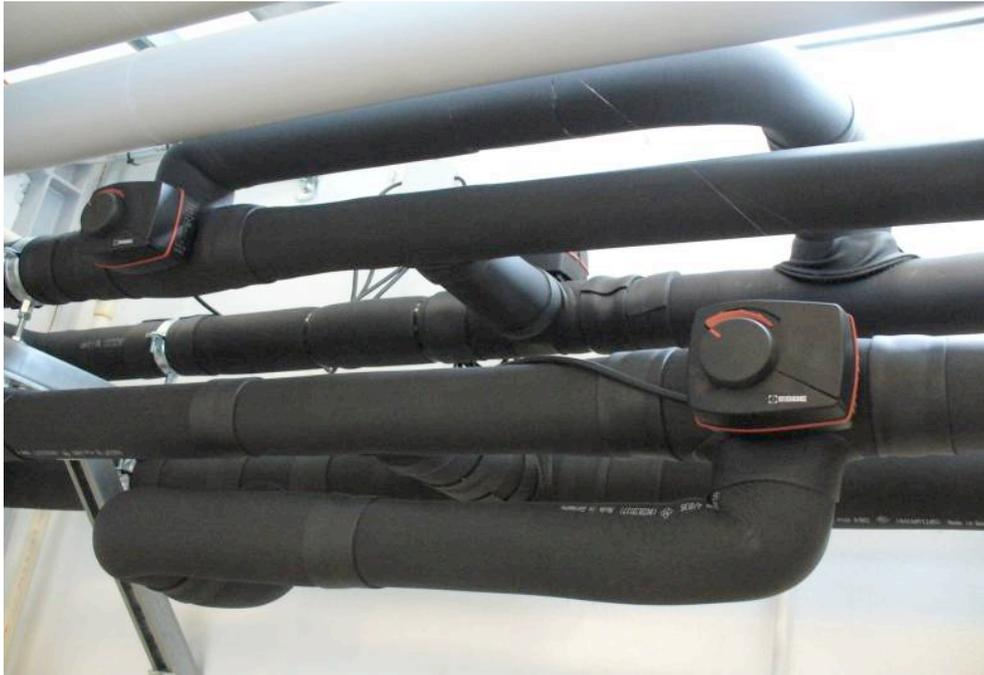
Bild 4: Dreiwegeventile für den Wärmepumpenbetrieb
