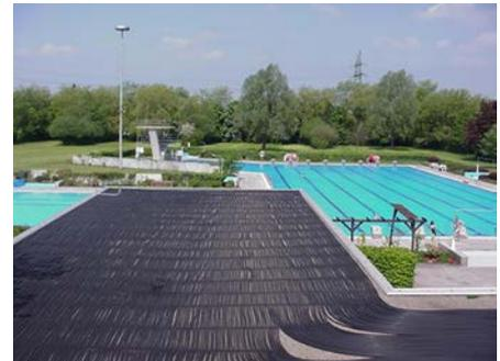
*Das Freibad Emden wird mit einer Wärmepumpe, die als Quelle Solarmattenabsorber nutzt, beheizt.*
