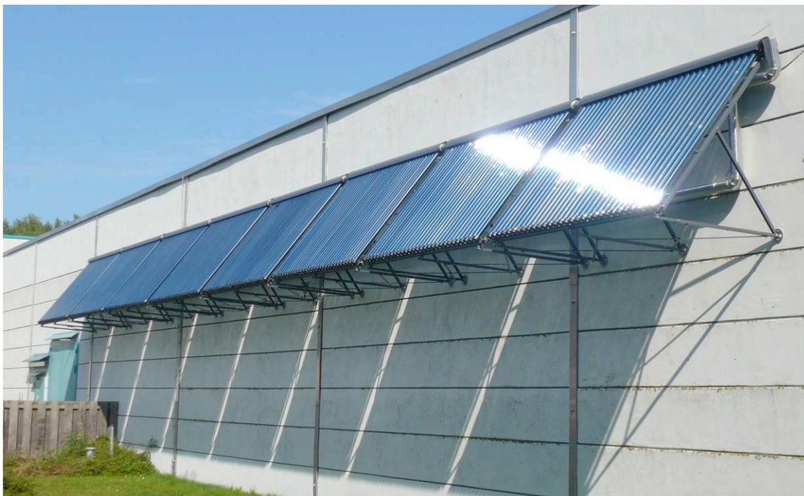
Bild 2: Vakuumröhrenkollektorfeld an der Fassade der Teststandhalle
