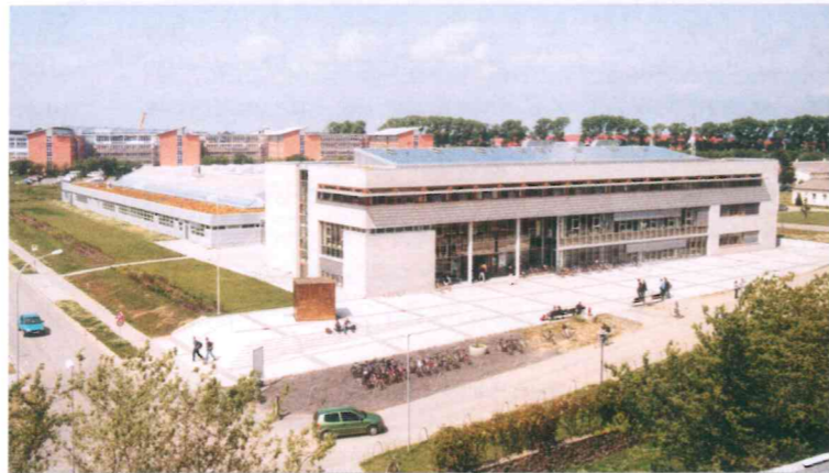
Der Neubau des Fachbereiches Maschinenbau ist der erste Hochschulneubau des Landes Mecklenburg-Vorpommern
