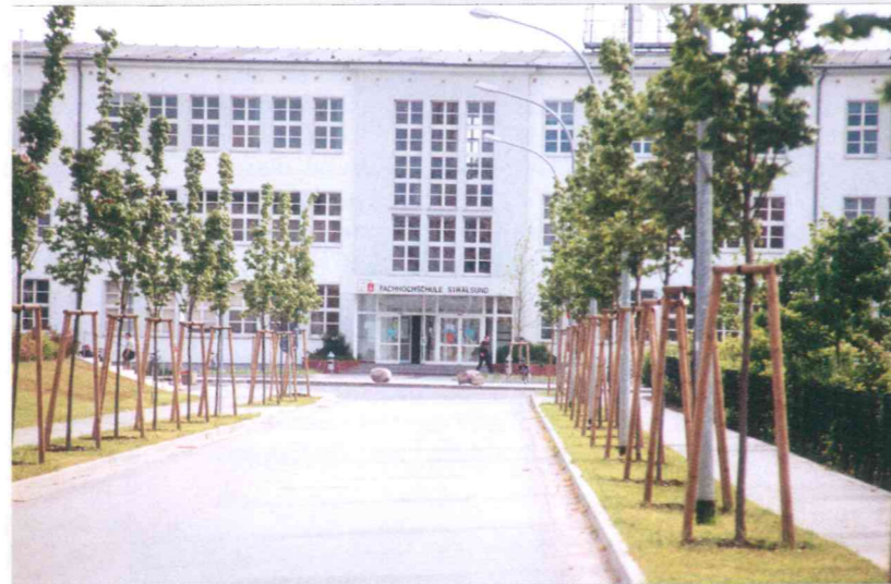
Das Labor- und Seminargebäude des Fachbereiches Elektronik und Informatik bildet den Mittelpunkt des Hochschulcampuses
