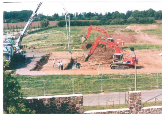
Der erste Beton für den Neubau des Fachbereichs Maschinenbau fließt
