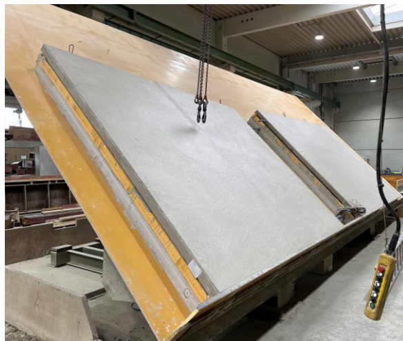
Abbildung 8: Herstellung von Sandwichfassaden-Elementen im Fertigteilwerk Otto Knecht
