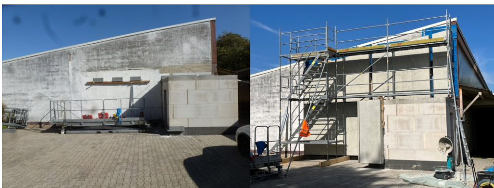
Abbildung 9: Umsetzung der Demonstrationsfassade bei KOMZET BAU in Bühl in Ausgangslage (links) und mit montierten Sandwichfassaden-Elementen (rechts)
