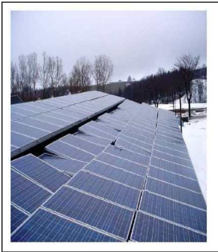
Bilder 3 und 4: Schneelasteinflüsse – unterdimensioniertes Montagesystem und Modulbeschädigungen
