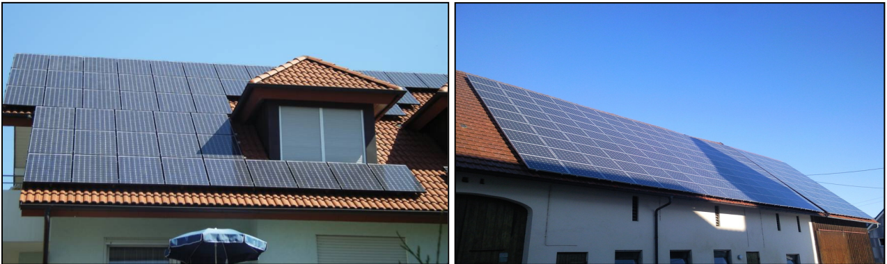
Bilder 8 und 9: Verschattung durch Dachgauben bzw. benachbarte Gebäude
