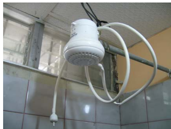
Durchlauferhitzer-Duschkopf (ca. 5 kW)
