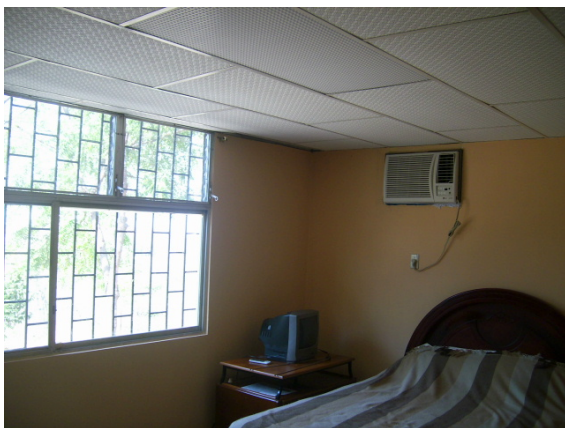
Kompakt- Klimagerät Kühlleistung: 24.000 Btu/h (ca.7 kW) el. Anschlussleistung: 2,82 kW
