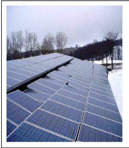
Bilder 3 und 4: Schneelasteinflüsse – unterdimensioniertes Montagesystem und Modulbeschädigungen
